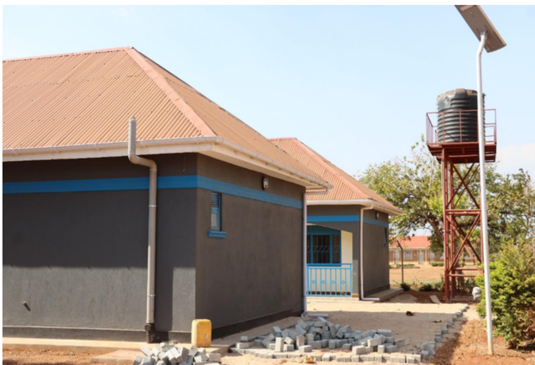
Imagen 4: Instalación de dos tanques de agua para abastecer de agua el alojamiento del personal.
