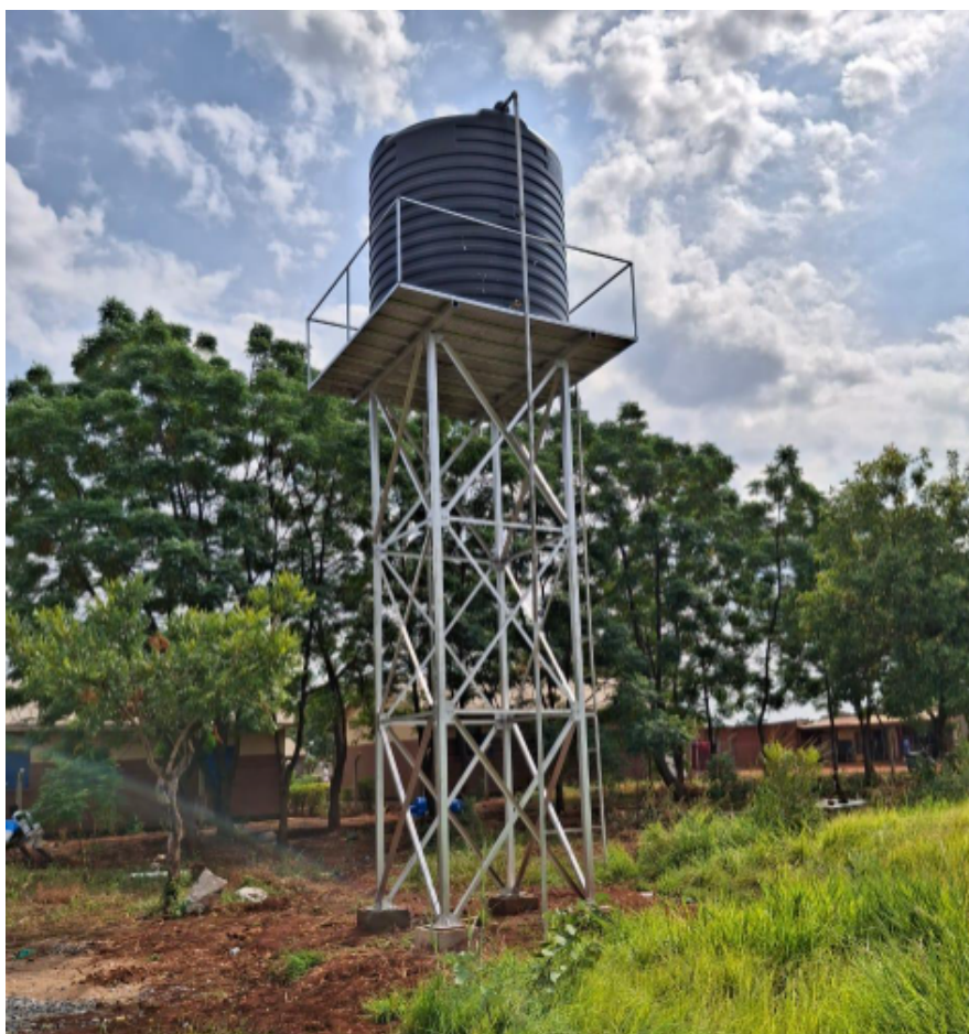
Imagen 2: Instalación de un depósito de agua de 10.000 litros sobre una torre de 6 metros de altura para la distribución de agua.
