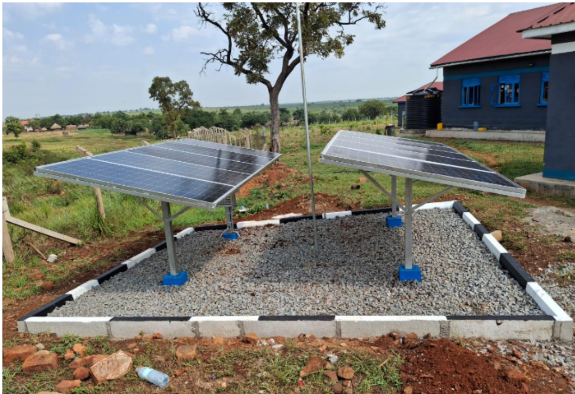
Imagen 1: Instalación de paneles solares para alimentar el sistema de bombeo motorizado
