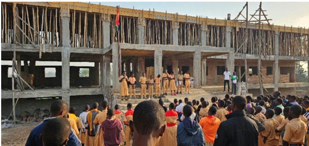
Construcción del edificio, donde ya se pueden ver: la planta baja, la primera y la segunda. Esta última está apuntalada porque se está terminando de construir.
