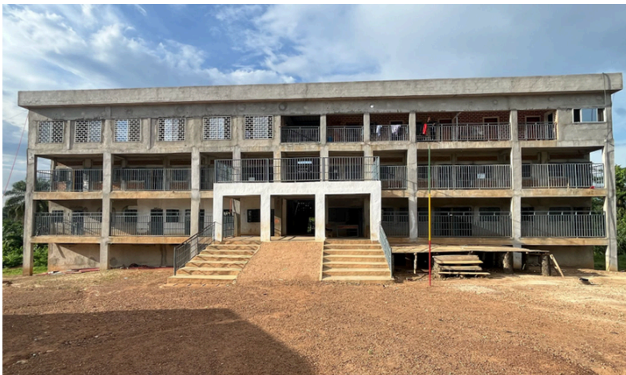
Vista general de la escuela de primaria y secundaria de FyA Guinea en Souhoulé
