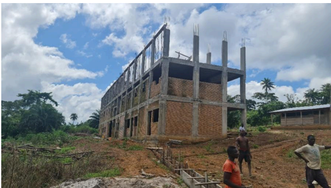
Proceso de levantado de muros de las aulas en la planta baja y en la planta primera con los ladrillos de tierra.
