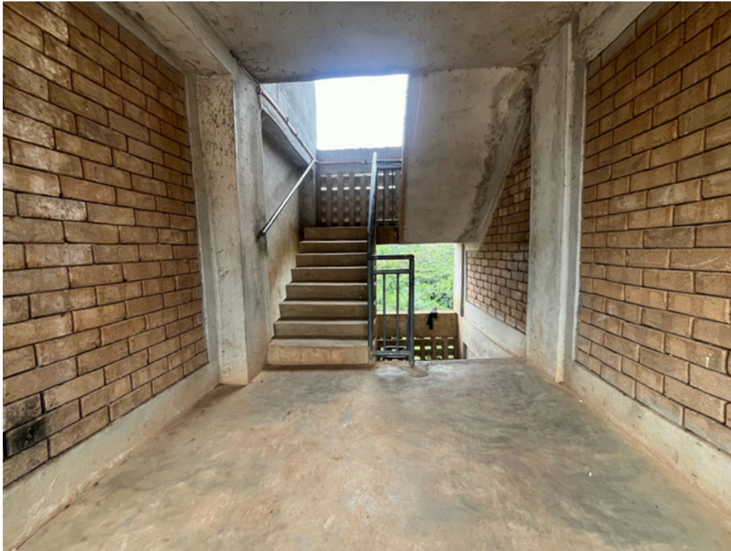
Zona de escaleras
